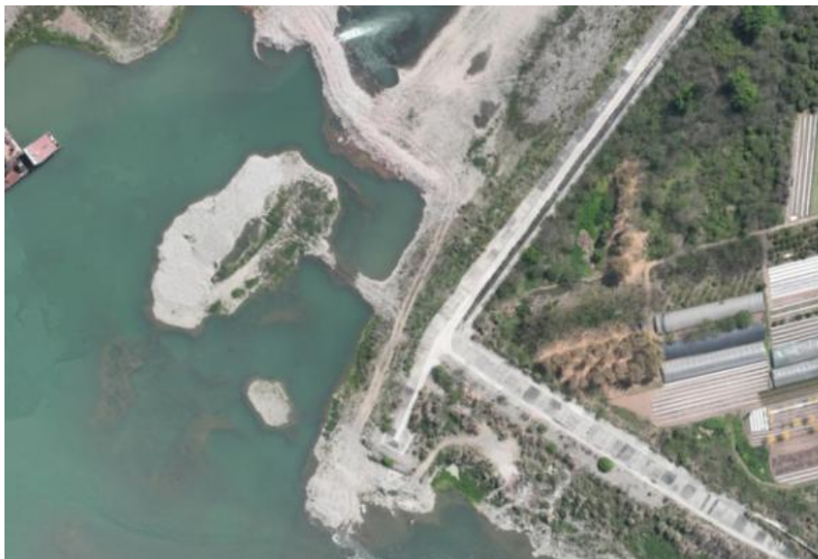
图3-14 汤家坝堤防现状
