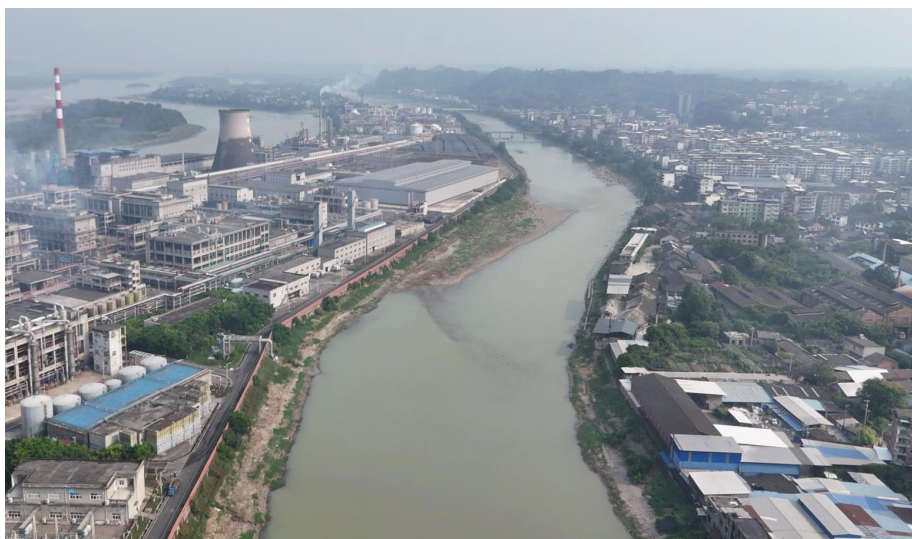
图3-16 和邦厂区堤防现状
