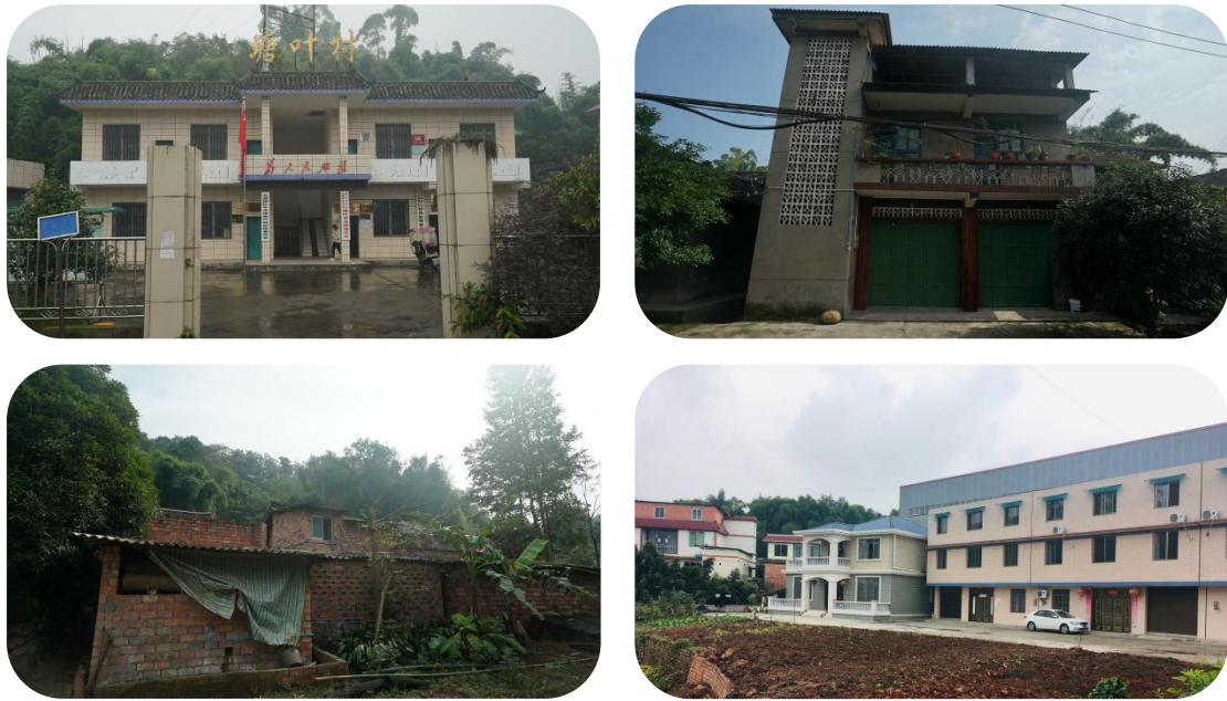
图 2-5 塘叶村建筑现状图
