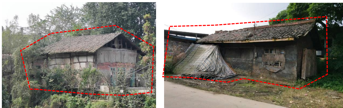
图 4-10 拆除建筑示意图
